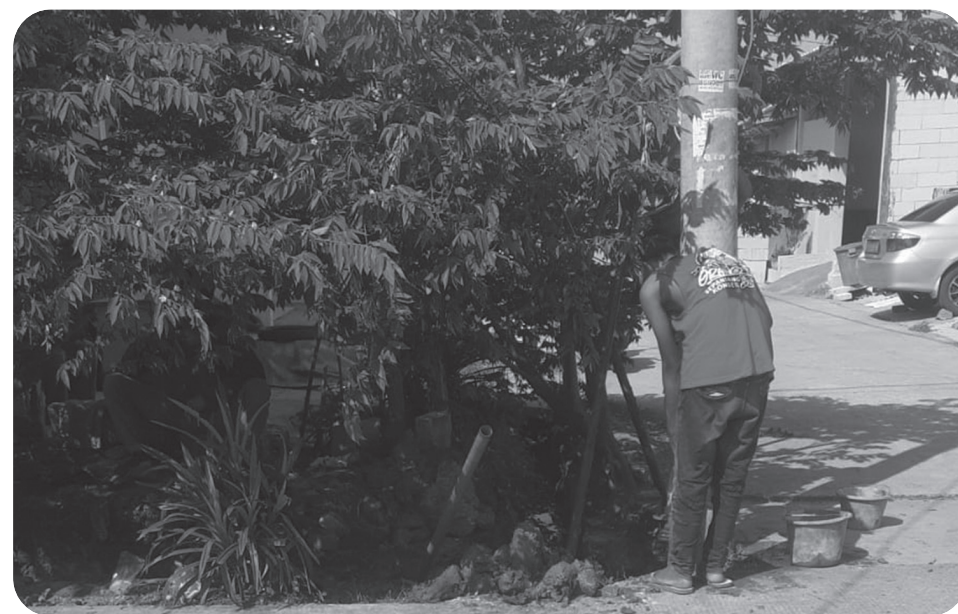
Pemasangan tiang internet di Kecamatan Rajeg.
